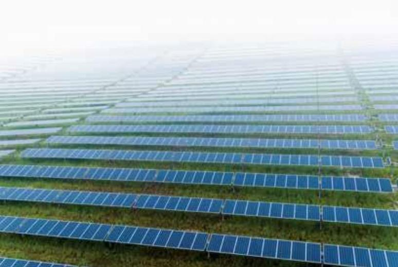
**OPTIMIZACIÓN CON CIELO DIFUSO** En condiciones de cielo nublado, la luz solar se dispersa casi isotrópicamente, lo que significa que se origina uniformemente desde todas las direcciones de la bóveda celeste. Para captar la energía de una manera óptima, TrueCapture abre el área de apertura del módulo hacia la bóveda celeste, con lo que se mejoran las ganancias diarias hasta en un 30 % en condiciones nubladas.
